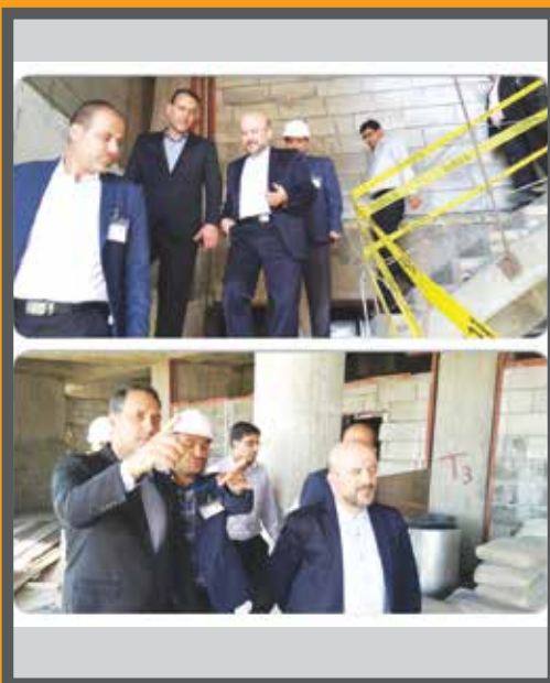
حضور مهندس علیزاده معاون وزیر راه و شهرسازی و هیات همراه جهت بازدید و مساعدت بیشتر در اتمام پروژه ساخت بیمارستان امام حسین(ع) به دعوت دکتر سعید باستانی
