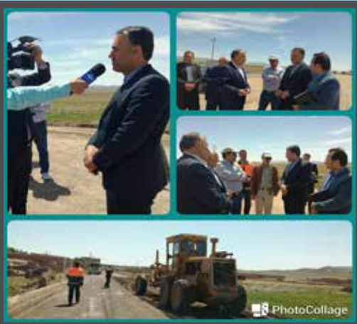
عملیات اجرایی پروژه بهسازی جاده حشمت آباد به چخماق شهرستان زاوه به طول ۱۷ کیلومتر
