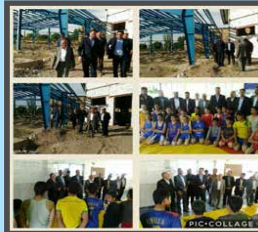
پیشرفت فیزیکی پروژه خانه کشتی شهرستان مه ولات
