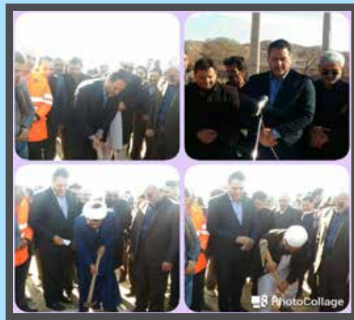
کلنگ زنی آسفالت روستای رحمت آباد زاوه
